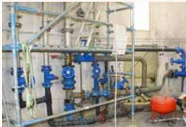
Des travaux importants ont été réalisés au château d'eau de Théza par Sud Roussillon, en raison de nombreuses fuites : reprise de l'étanchéité, remplacement de l'ensemble des équipements par des nouveaux éléments en inox (coût total des travaux : 85 000 €).
